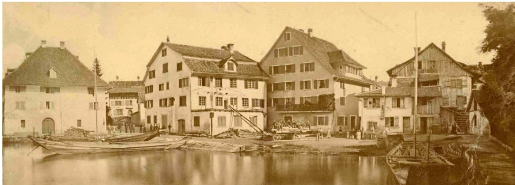
Susthafen mit Sust, Haus zum Schiff (Abbruchvorbereitungen für Eisenbahnbau) und Gerwe - 1873
